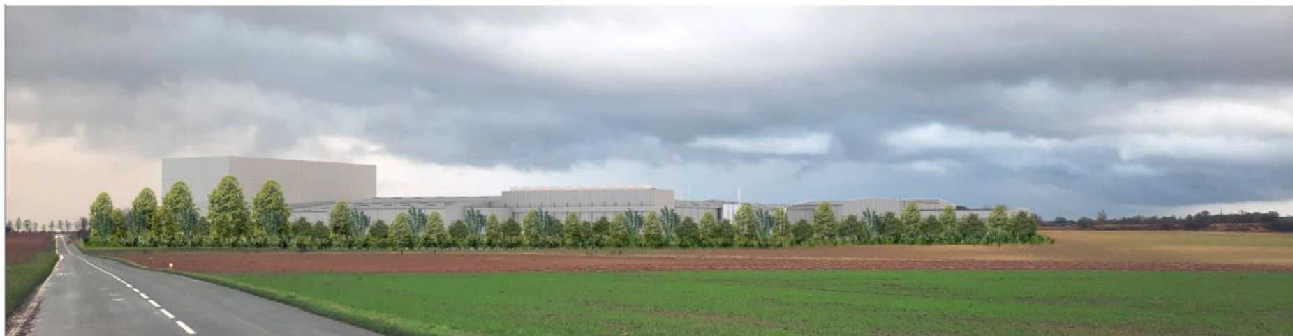
Illustration n° 19 : Insertion paysagère du site Ecofrost (Source : Dossier de demande de permis de construire du projet Ecofrost)
